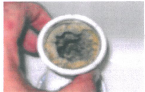
Le tuyau après utilisation de blocs pDCB
